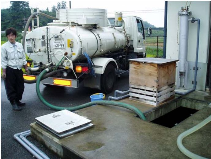
汚泥搬出状況
