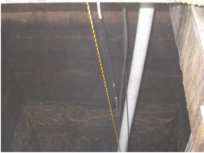
汚泥貯留槽 メカセラ水注入状況
