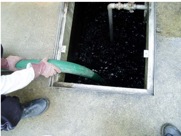
汚泥搬出 汚泥貯留槽内
