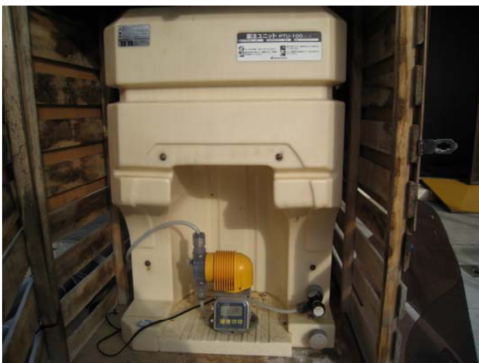
次亜塩素酸ナトリウム 滴下装置
