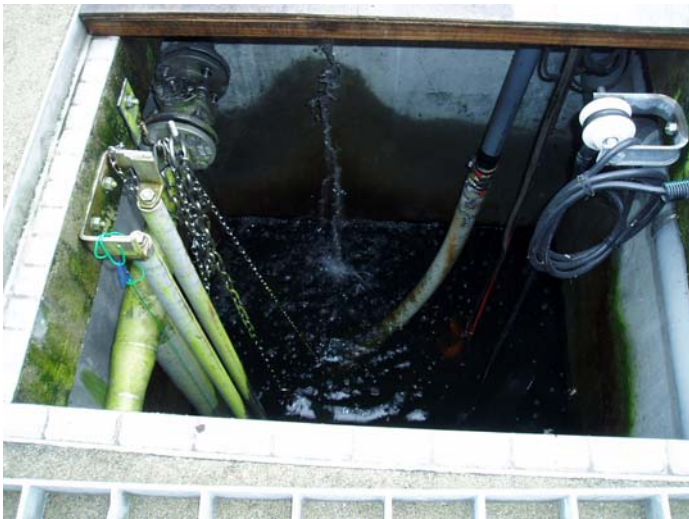
散水ポンプ槽取水状況
