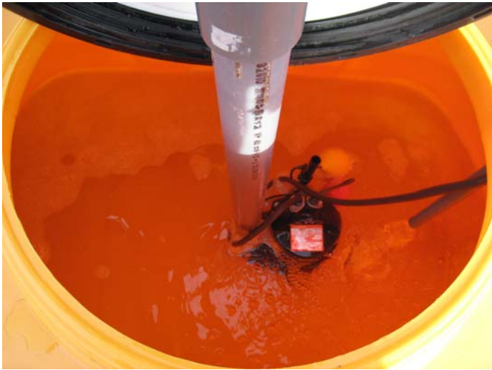
メカセラ水貯留タンク内部
