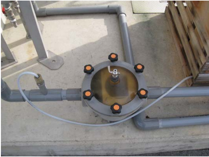
次亜塩素酸ナトリウム滴下部 および夾雑物除去部分
