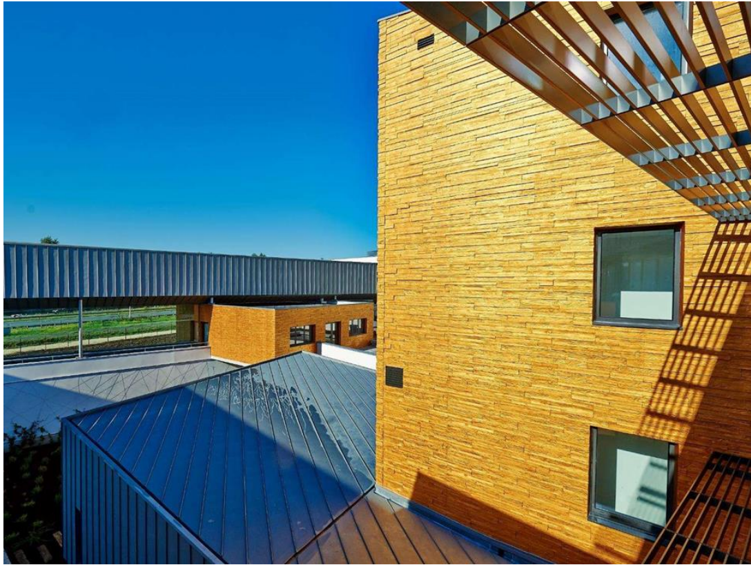
行政管理センター・外壁 D1753
