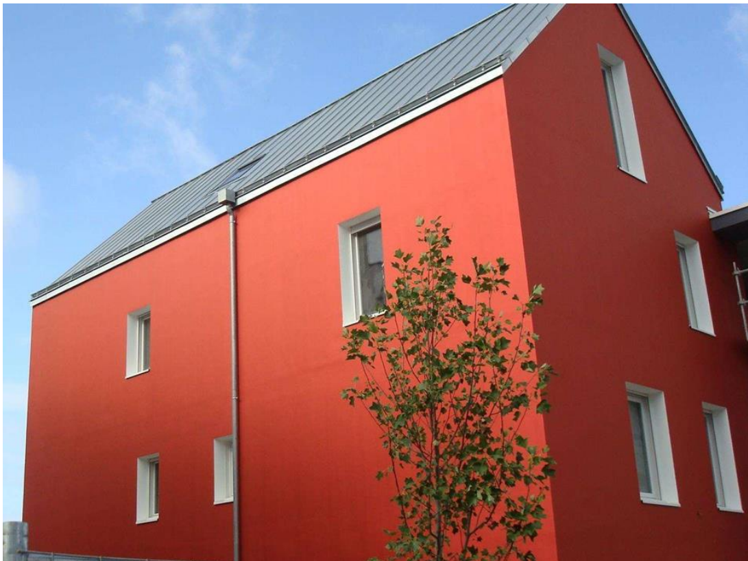
住宅・外壁 Nantes, フランス D1004
